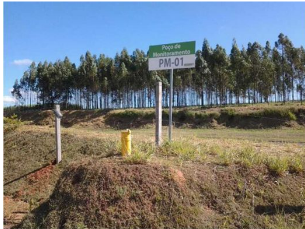
Figura 22 - Poço de monitoramento das águas subterrâneas.
