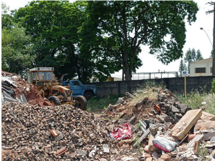
Figura 39 - Local de acondicionamento de RCC.
